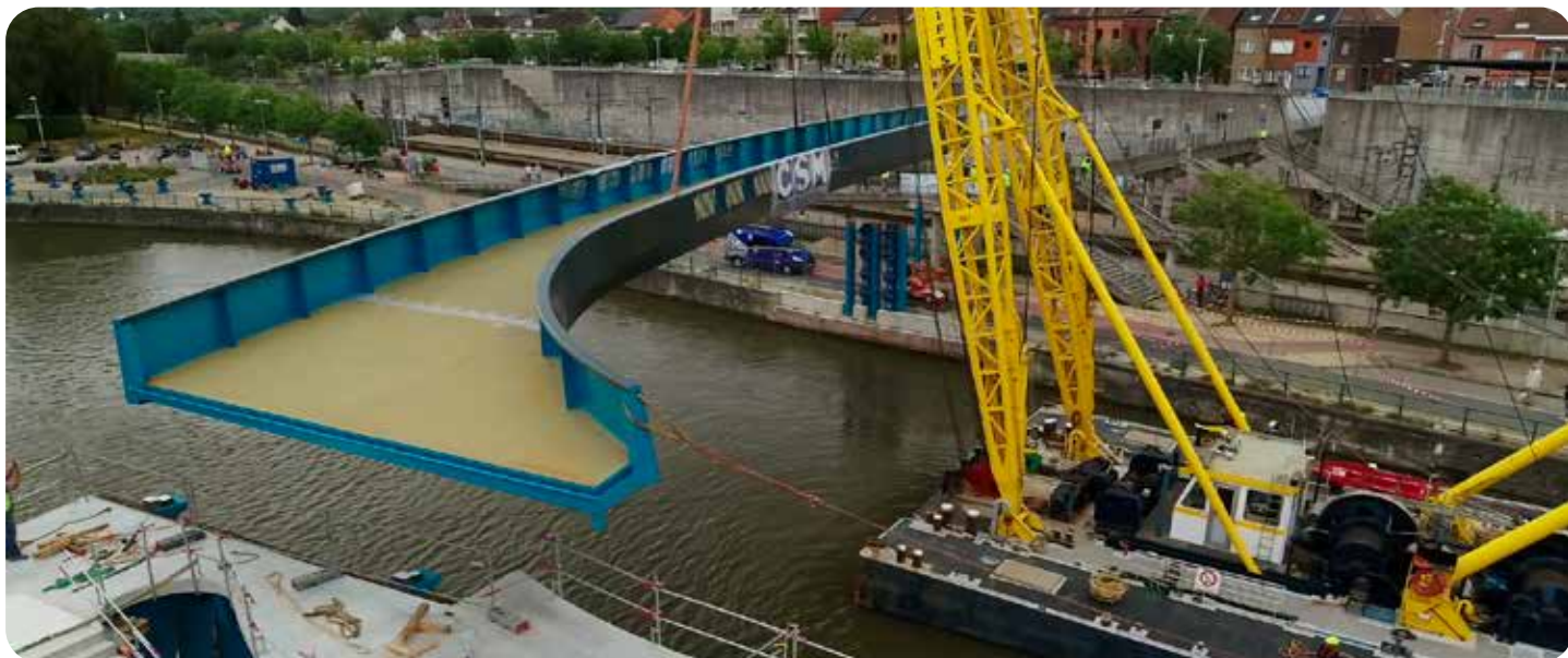
Eind augustus werd de Klarabrug geplaatst.
